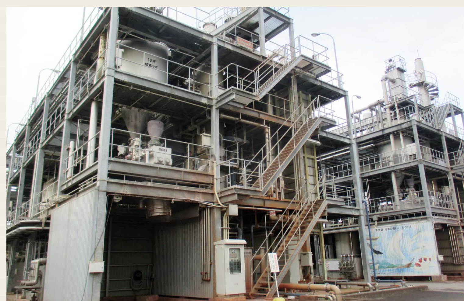
茨 城 県 流 域 下 水 道 事 務 所 霞 ケ 浦 浄 化 センター
